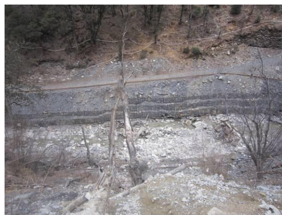
钢筋石笼临时拦挡
