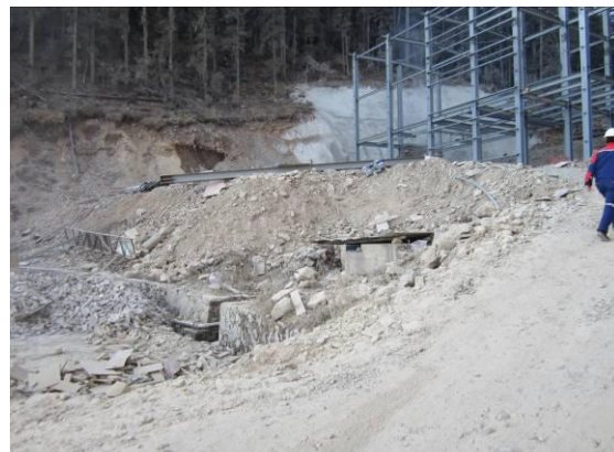
南回风井工业场地现状
