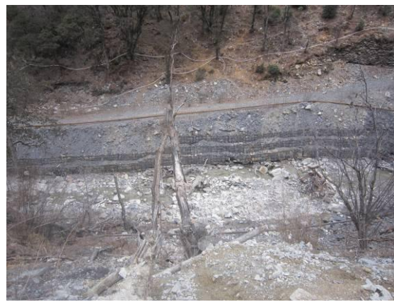
钢筋石笼临时拦挡
