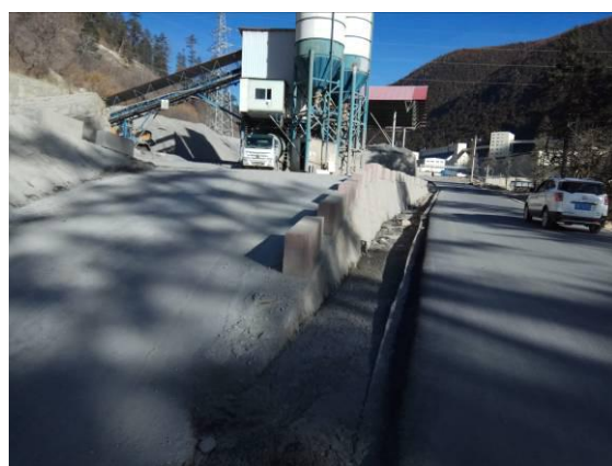
施工营场地（拌和站）
