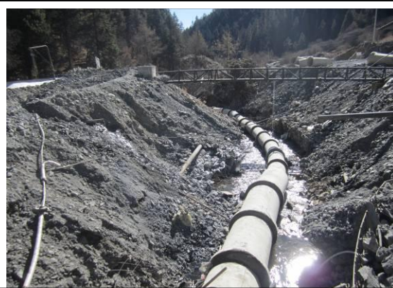
尾矿管隧洞出口施工场地预制涵管埋设
