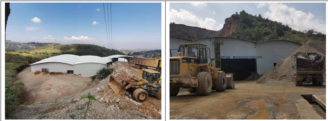
工业场地 监测内容：措施实施水土流失情况
